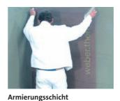
Der Armierungsmörtel wird ca. 5 bis 7 mm dick auf die Dämmplatten aufgetragen und plangezogen. Anschließend wird das Armierungsgewebe in senkrechten oder waagerechten Bahnen, mit Glätter oder Traufel, faltenfrei in den Armierungsmörtel eingedrückt.
