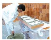
Aufbringen des Klebemörtels Der Klebemörtel wird rahmenförmig mit drei senkrechten Stegen auf die Dämmplatte aufgebracht.
